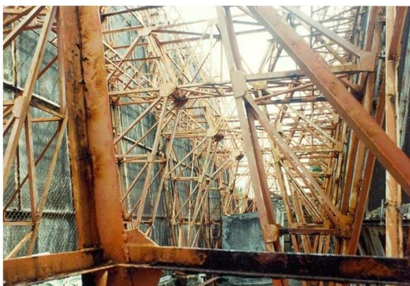
Figura 6. Estructura metálica que soportaba los paneles de asbesto-cemento del Mural N°3 exterior de La Tallera (1964-1965). Fotografía del Archivo interno del CENCROPAM-INBA
