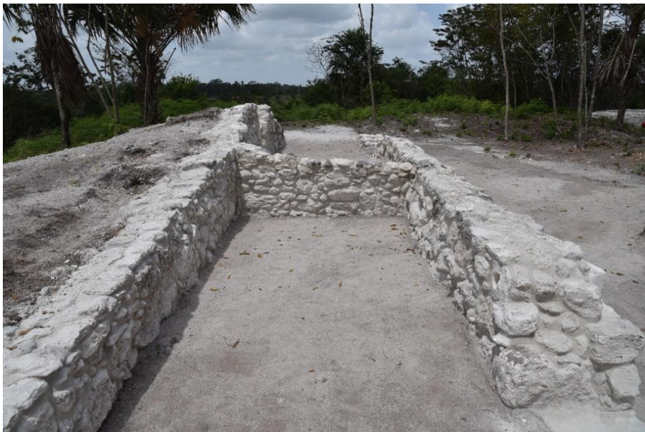
Figura 2.28. Estructura GZ3, vista sur. Después de la consolidación.
