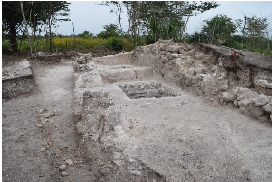
Figura 2.25. Estructura GZ3, vista oeste. Antes de la consolidación.
