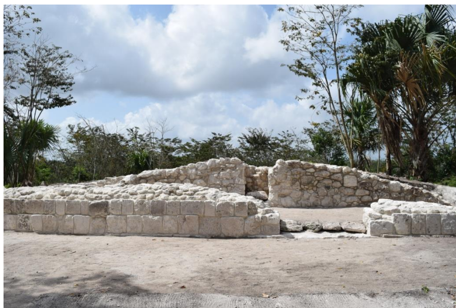
Figura 2.22. Estructura GZ3, vista norte. Después de la consolidación.
