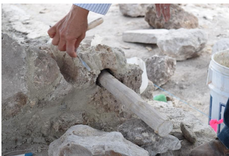
Figura 2.19. Restauración de orificios en la jamba oeste, del cuarto poniente.
