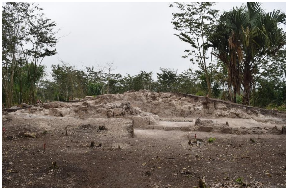
Figura 2.21. Estructura GZ3, vista norte. Antes de la consolidación.
