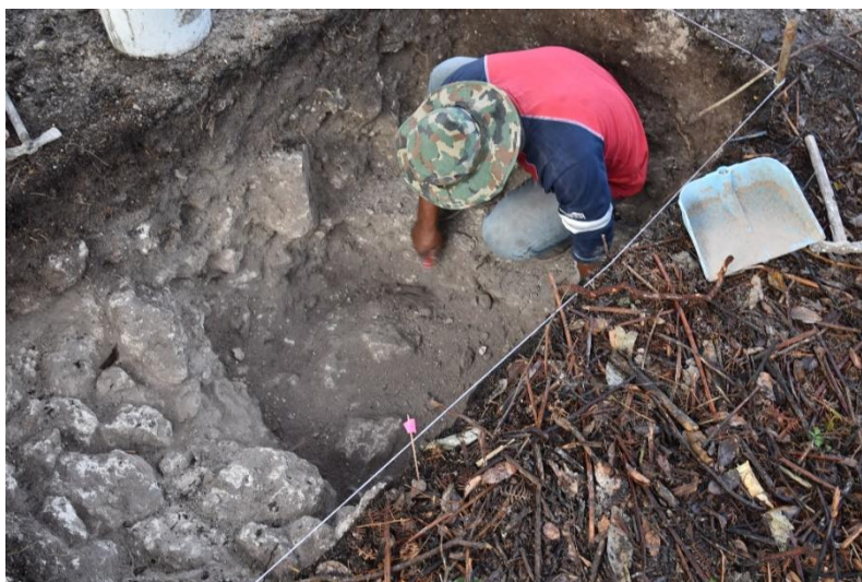
Figura 2.6. Área de excavación de la trinchera en el cuarto poniente, con piso deteriorado.
