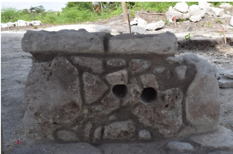
Figura 2.20. Orificios en jamba oeste, una vez restaurados.
